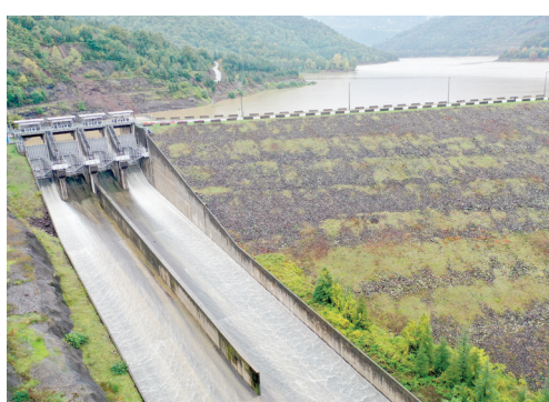
ÖNLEM ALINDI: Yuvacık Barajı'nda artan su seviyesi sonrasında ani taşkınları önlemek için kapaklar açılarak önlem alındı.
