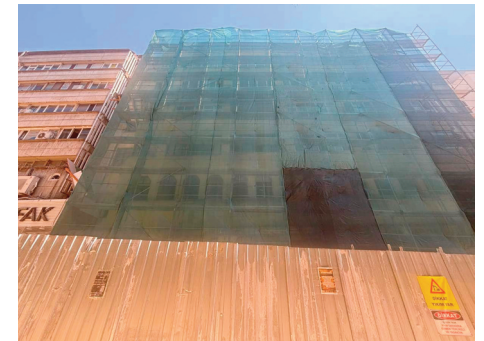
SON AŞAMA: Bilin Pasajı'nın yıkılması için güvenlik şartları çekildi. Kontrollü geçiş uygulaması yapıldı. Çevresi kapandı şimdi de kurulan iskeleye file asıldı.
