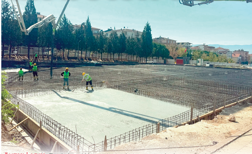
ÖNEMLİ ADIM: Zemin hazırlıklarının tamamlanmasının ardından şantiyede ilk beton dökümü gerçekleştirildi. Proje planlı bir çalışmayla ilerliyor.
