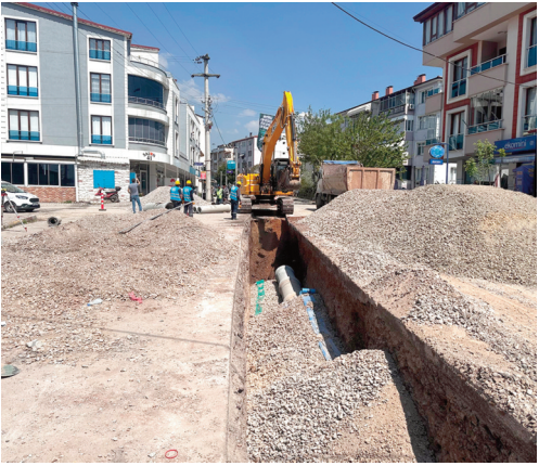
ÖNEMLİ YATIRIM: Mimar Sinan Mahallesi'nde yürütülen çalışmalar kapsamında altyapı hatları tamamen yenilenerek bölgeye güçlü bir sistem kazandırıldı.
